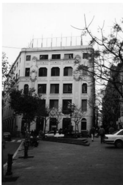
Fachada principal del IES Vila de Gràcia. Se puede apreciar su ubicación en pleno casco urbano, ocupando una edificación de 5 plantas y terraza en la que se ubica uno de los patios.
